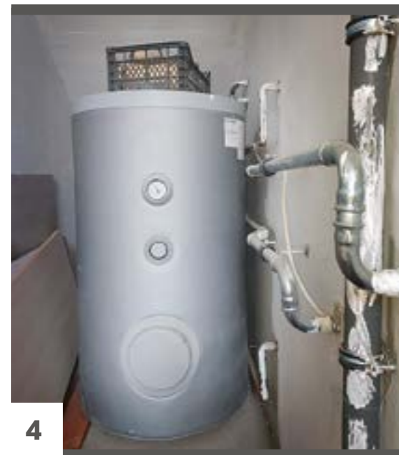
4. kép 200 literes Indirekt tároló egy tervezési hiba miatt a pincelejáróba került. 1 vékony fal választja el csak a gépészeti helyiségtől.
